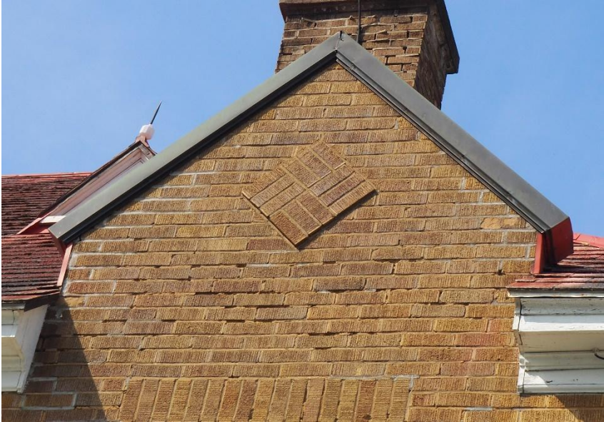
Fronton en briques ornementé d’une insertion en losange
