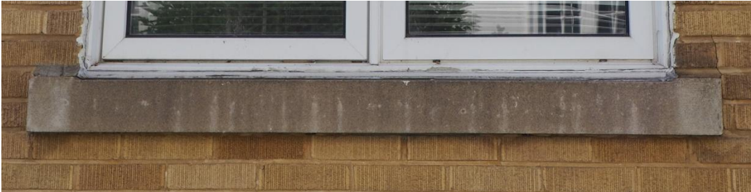
Allège (appui de fenêtre) en ciment
