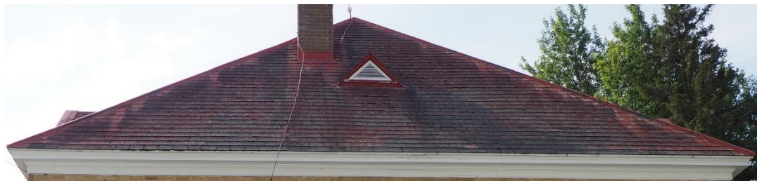
Toiture à croupes
