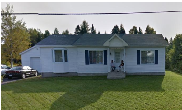
Unifamiliale (isolée), rue des Monts
